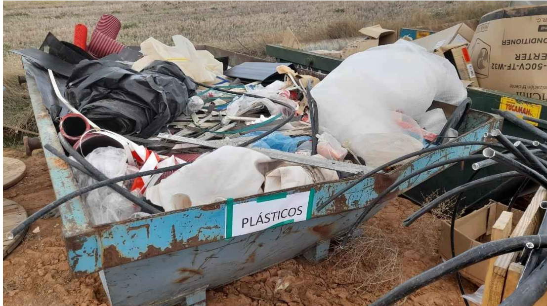
Foto 16. Zona de residuos de construcción y demolición (RCD). Contenedor de plásticos.
