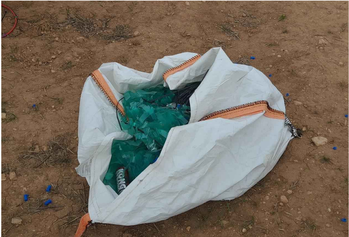
Foto 4. Acopio de flejes en zona de obra.
