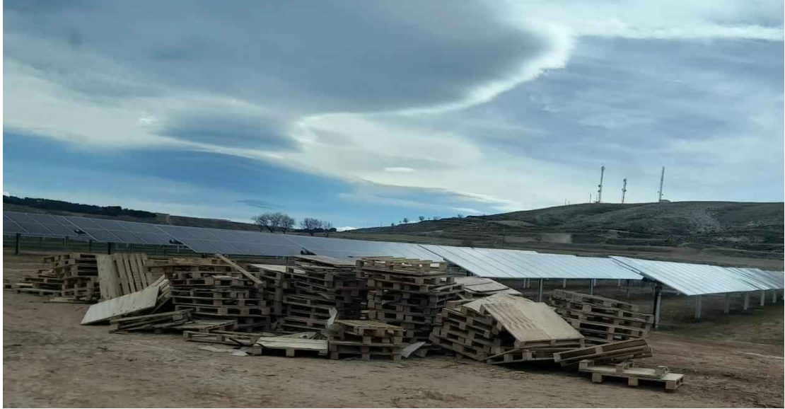
Foto 3. Acopio de madera en zona de obra.
