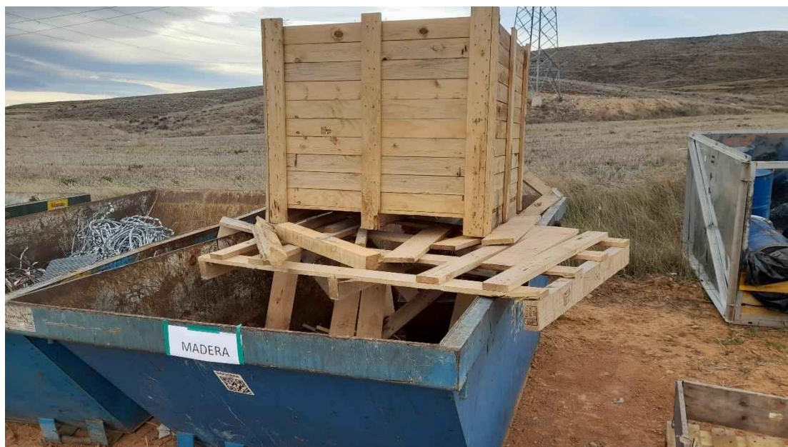
Foto 16. Zona de residuos de construcción y demolición (RCD). Contenedor de maderas.
