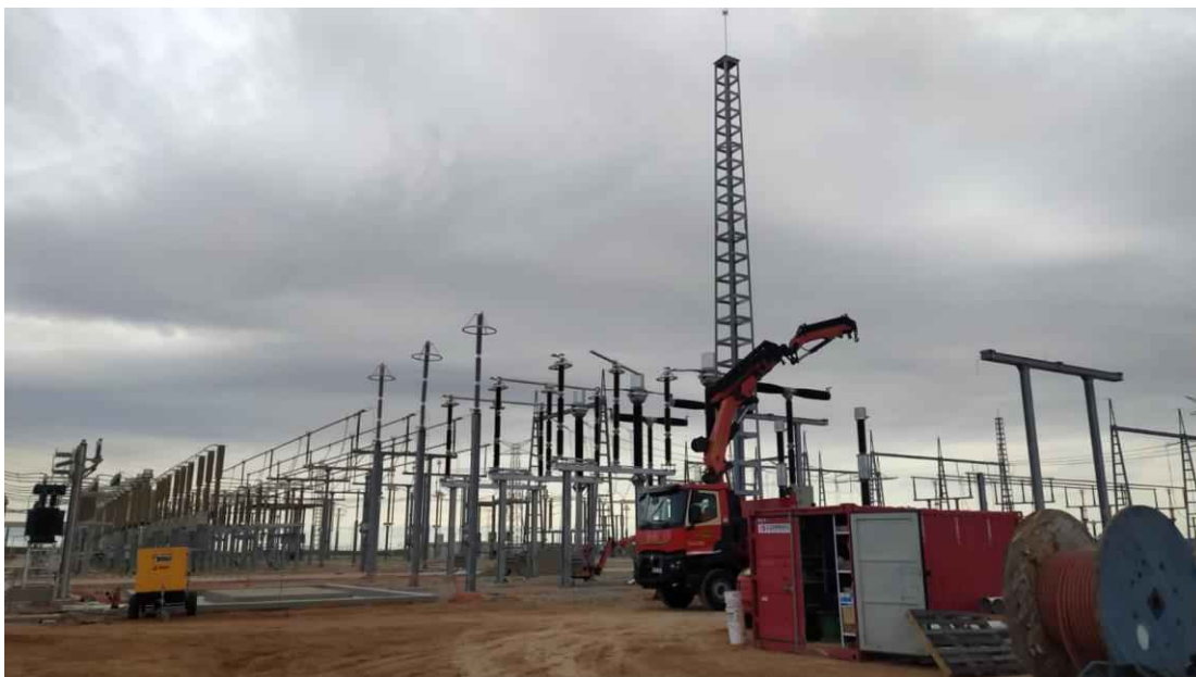
Foto 26. Vista general de la obra. Parte 2.
