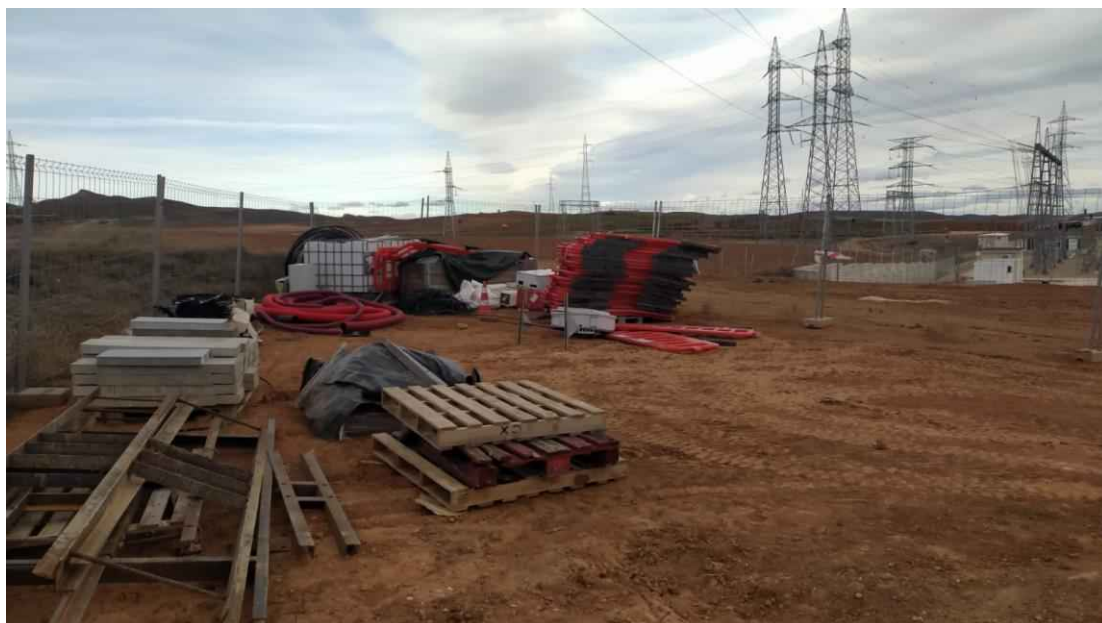
Foto 20. Zona de acopios.
