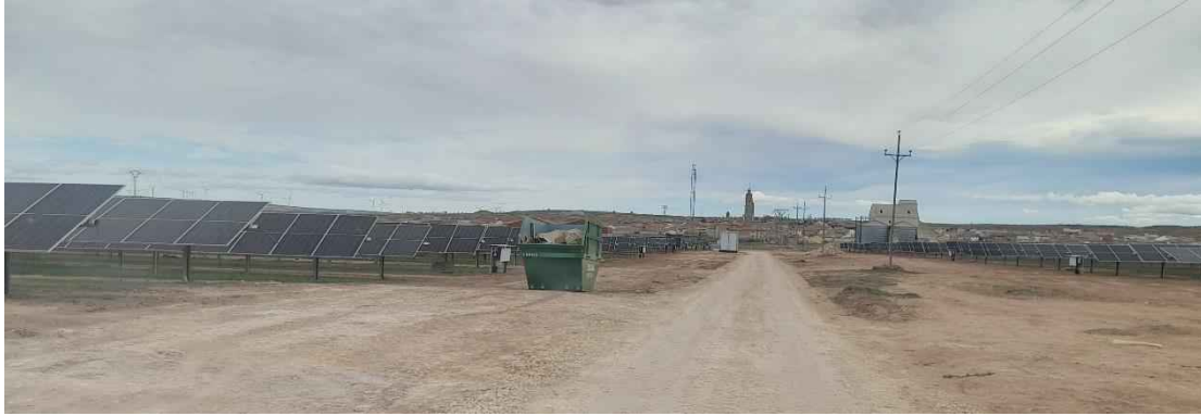
Foto 1. Contenedores de papel y cartón en zona de obra.
