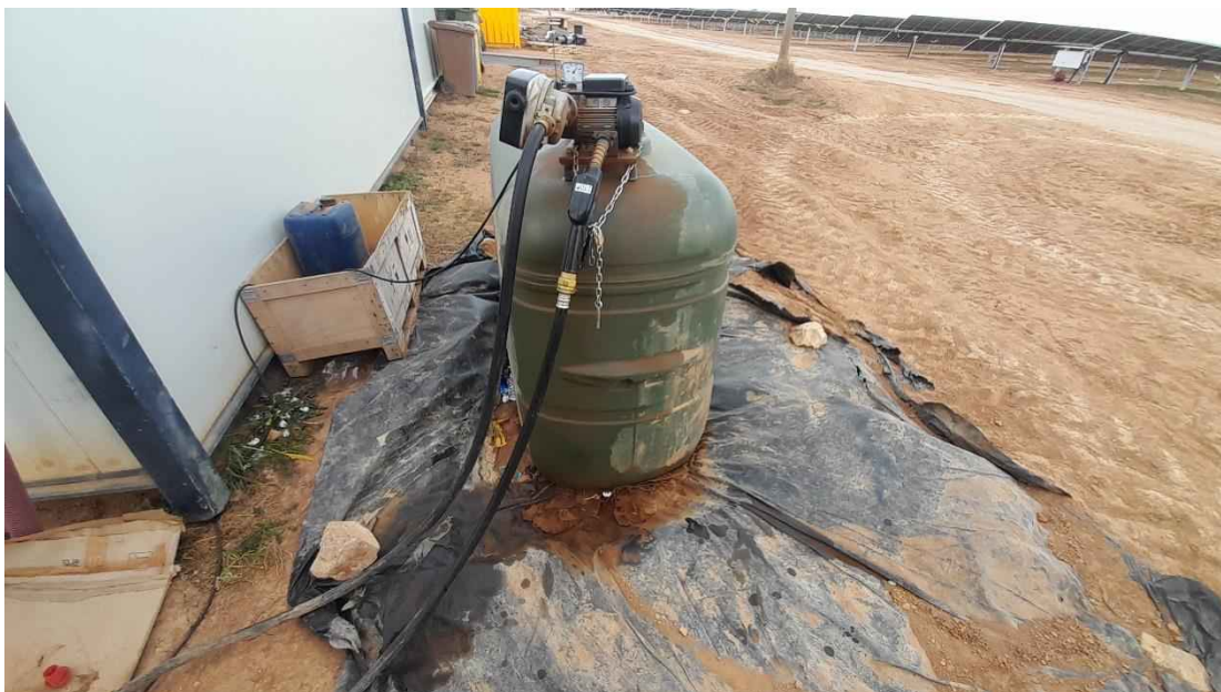
Foto 5. Depósito de gasoil en la zona de oficinas e instalaciones auxiliares.
