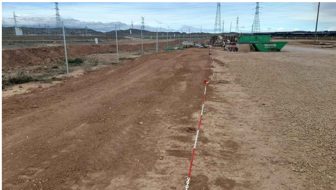
Foto 14. Preparación de la franja vegetal de 8 m de anchura en torno al vallado perimetral.
