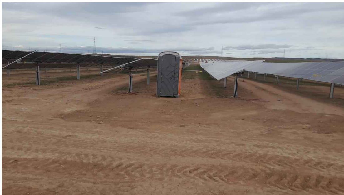
Foto 9. WC químico en zona de obra.
