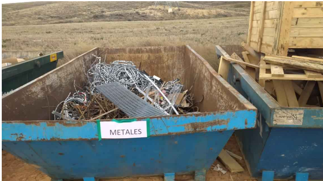
Foto 16. Zona de residuos de construcción y demolición. (RCD). Contenedor de metales.
