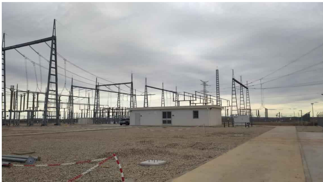
Foto 27. Inicio de los trabajos para la conexión de la ampliación con la Subestación Muniesa Promotores. Parte 1.
