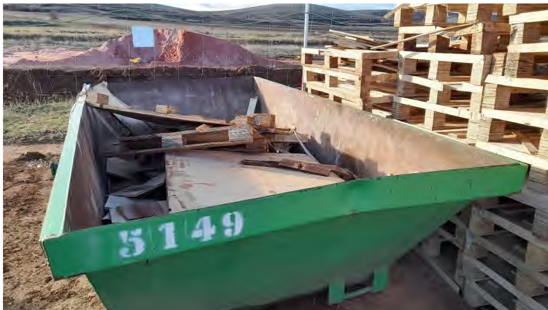
Foto 5. Zona de residuos de construcción y demolición (RCD). Contenedor de madera.
