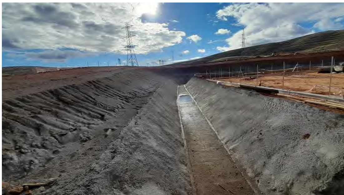
Foto 28. Aspecto de la cuneta de drenaje perimetral
