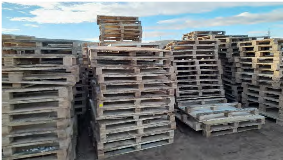
Foto 6. Zona de residuos de construcción y demolición (RCD). Acopio de madera.
