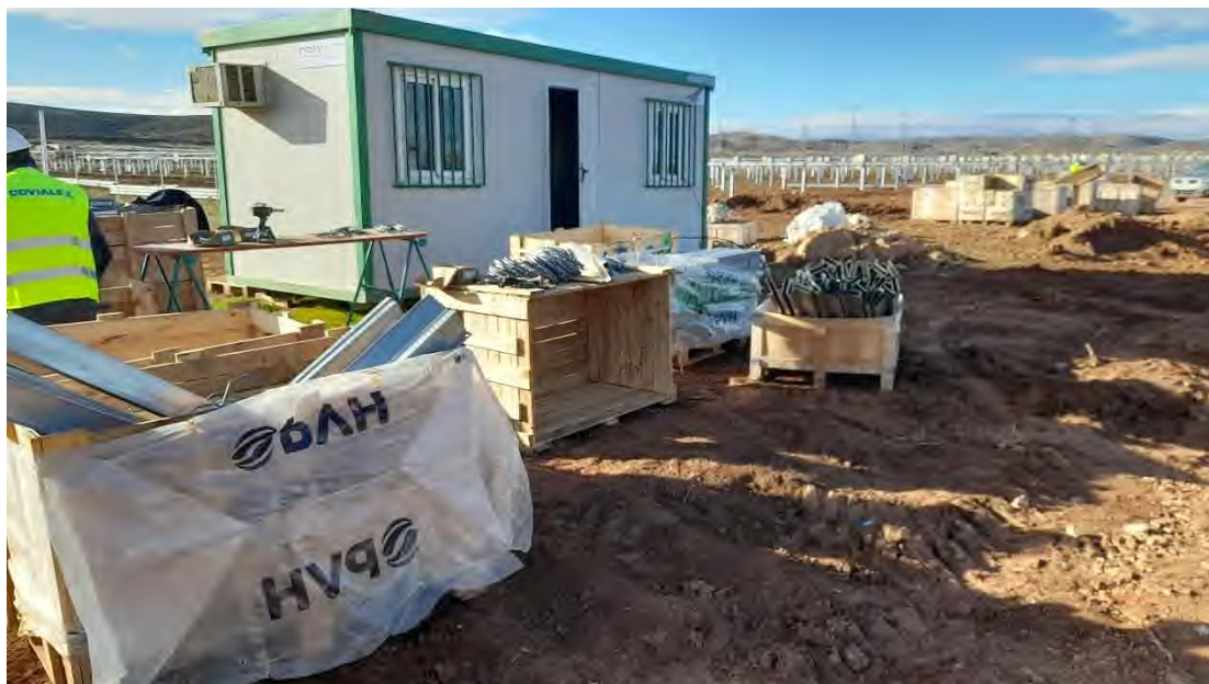
Foto 13. Zona de premontaje de seguidores
