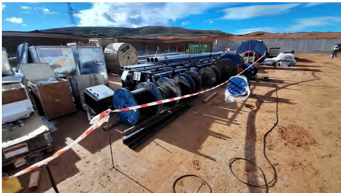
Foto 25. Acopios en zona de ejecución de la ampliación de la subestación.
