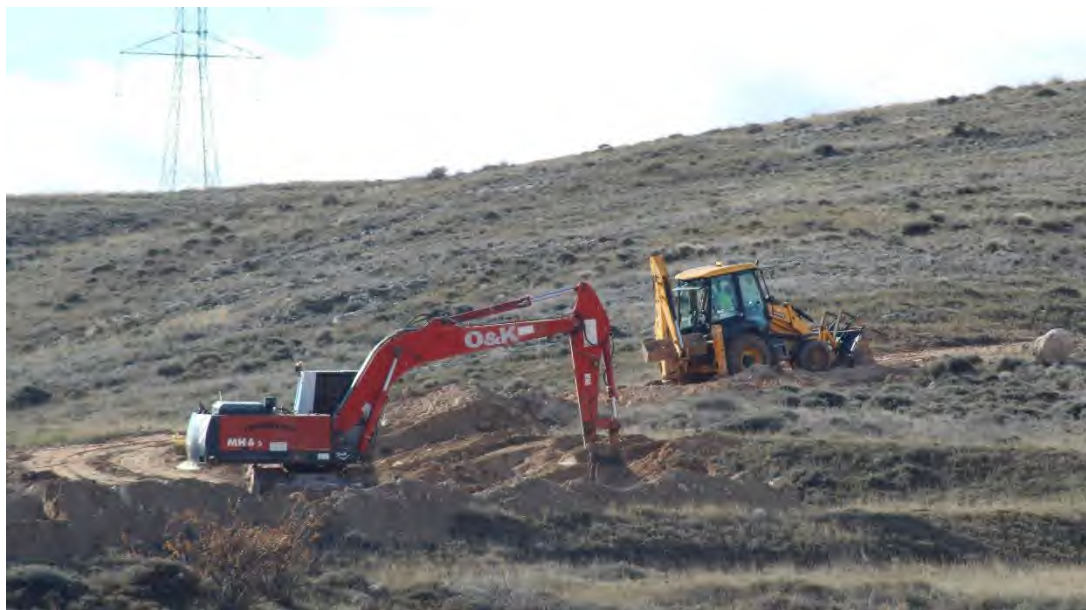
Foto 19. Trabajos de apertura de zanja de la línea de evacuación a la Ampliación de la SET Muniesa promotores.
