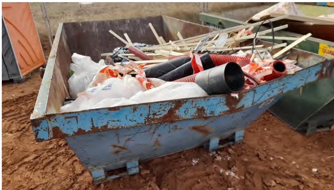
Foto 16. Zona de residuos de construcción y demolición (RCD). Contenedor de plásticos.
