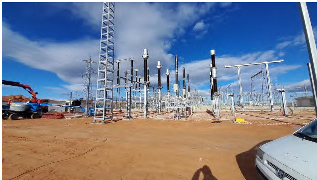
Foto 26. Avance del montaje de embarrados.
