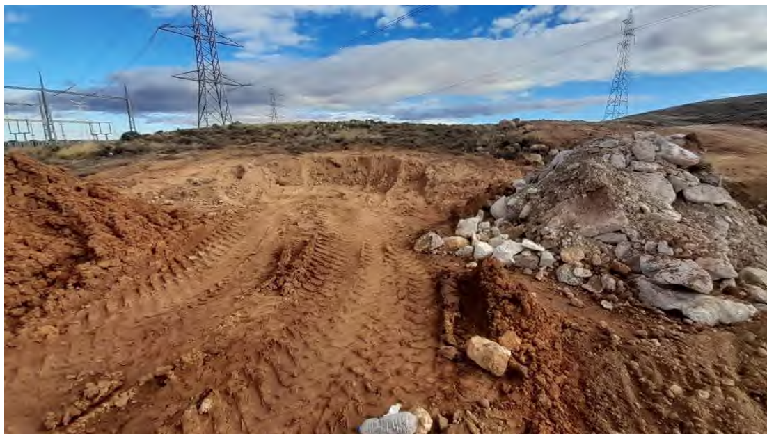
Foto 29. Zona de lavado de canaletas de hormigonera desmantelada con acopio de hormigón picado a la derecha.
