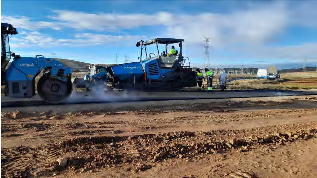
Foto 17. Extendido de aglomerado en el entronque del vial de acceso con la carretera
