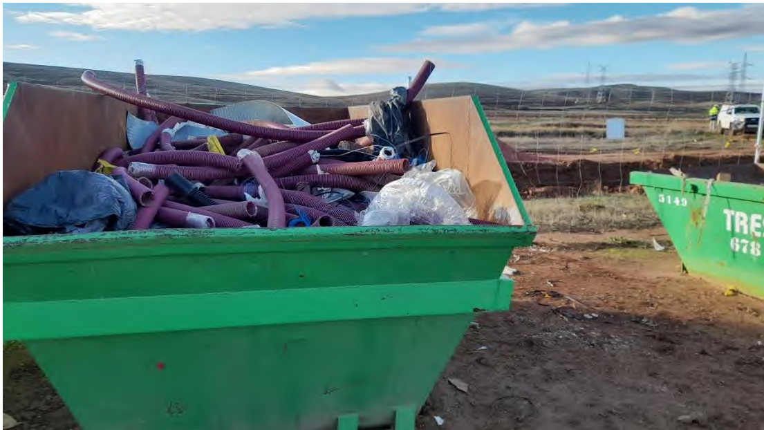
Foto 2. Zona de residuos de construcción y demolición (RCD). Contenedor de plásticos y envases
