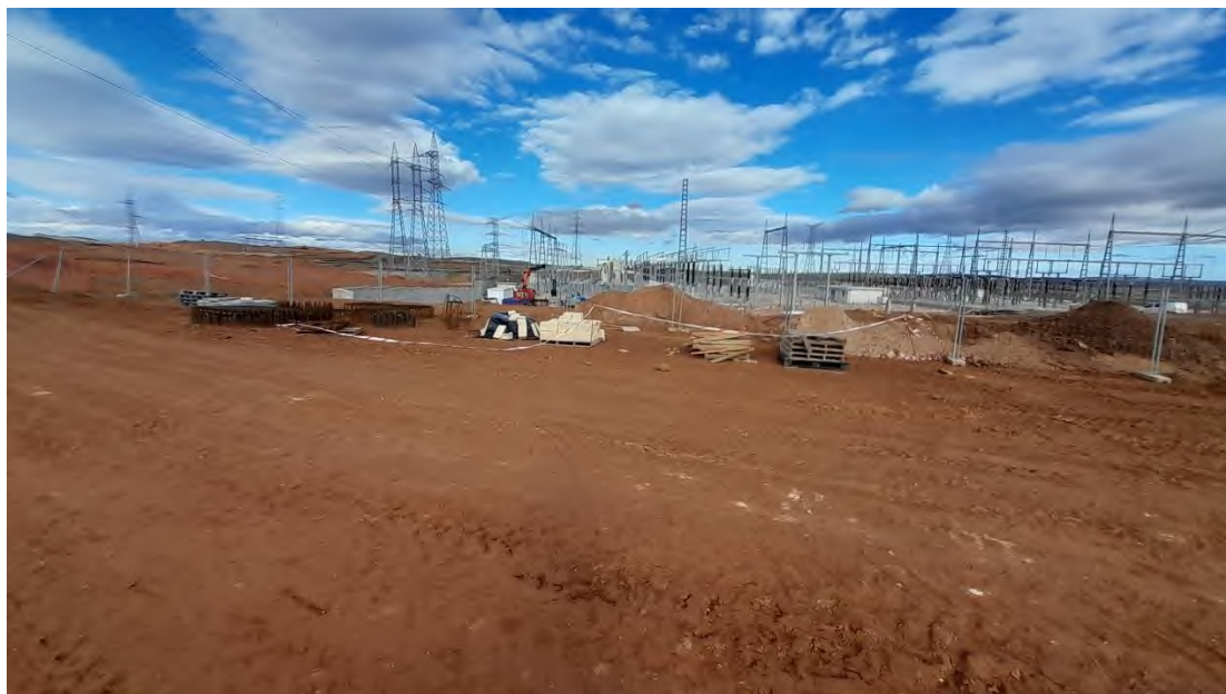
Foto 23. Zona de acopios.
