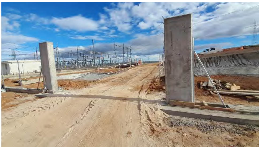
Foto 24. Futuro acceso a la ampliación de la subestación
