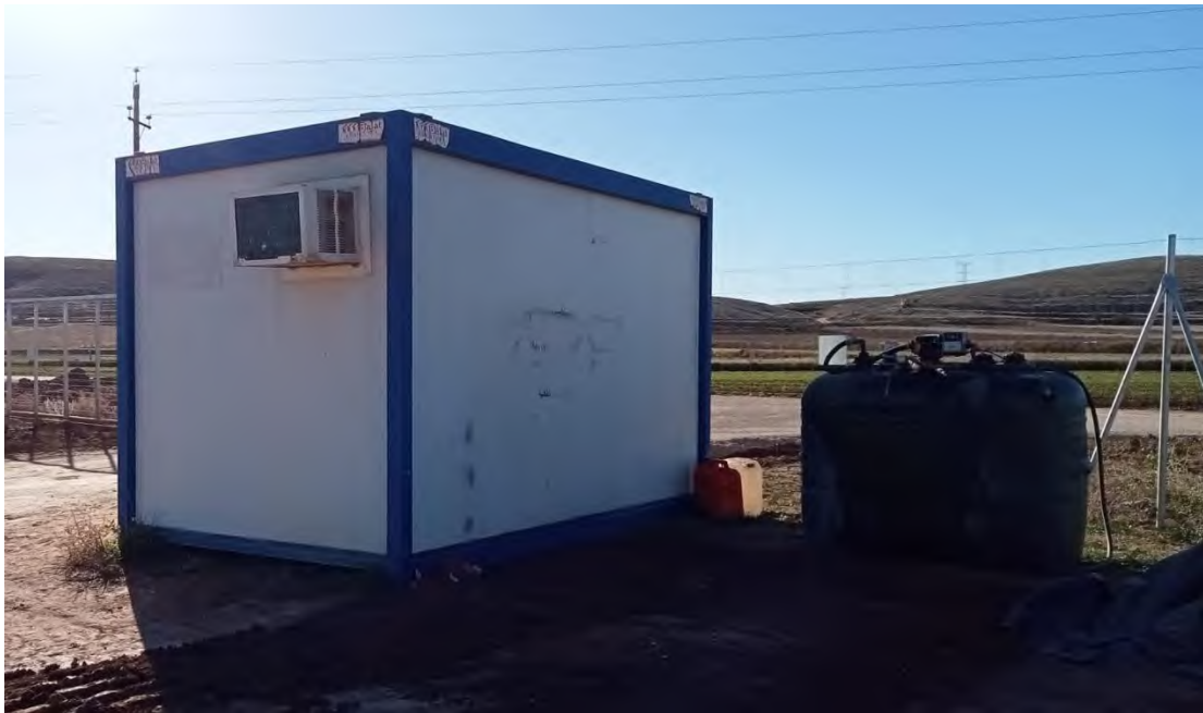
Foto 10. Depósito de gasoil en la zona de oficinas e instalaciones auxiliares.
