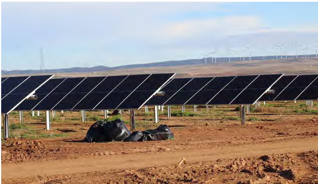
Foto 18. Acopios de residuos de embalajes de paneles fotovoltaicos preparados para su recogida.
