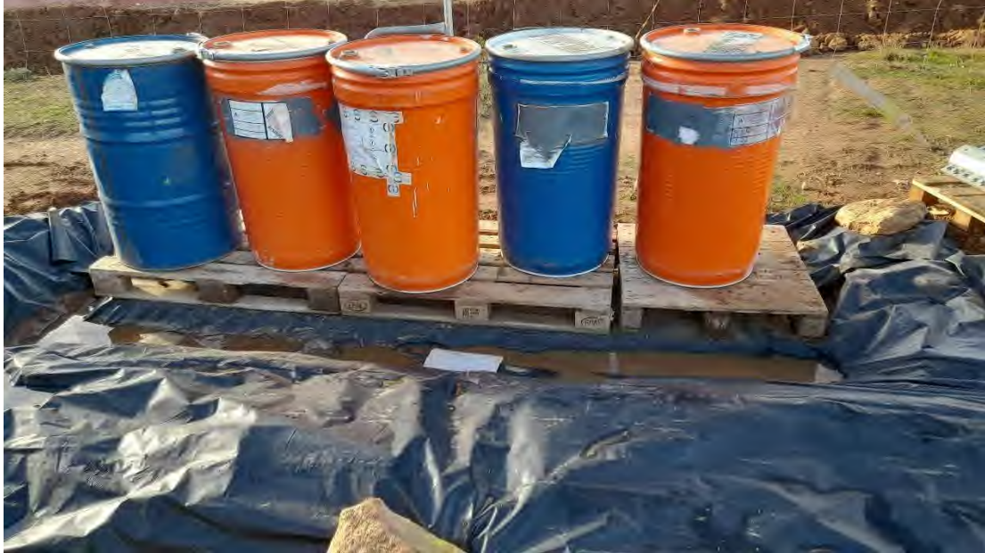
Foto 7. Contenedores para almacenamiento de residuos peligrosos
