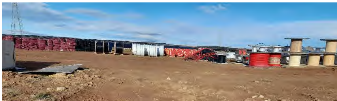
Foto 12. Zona de acopios
