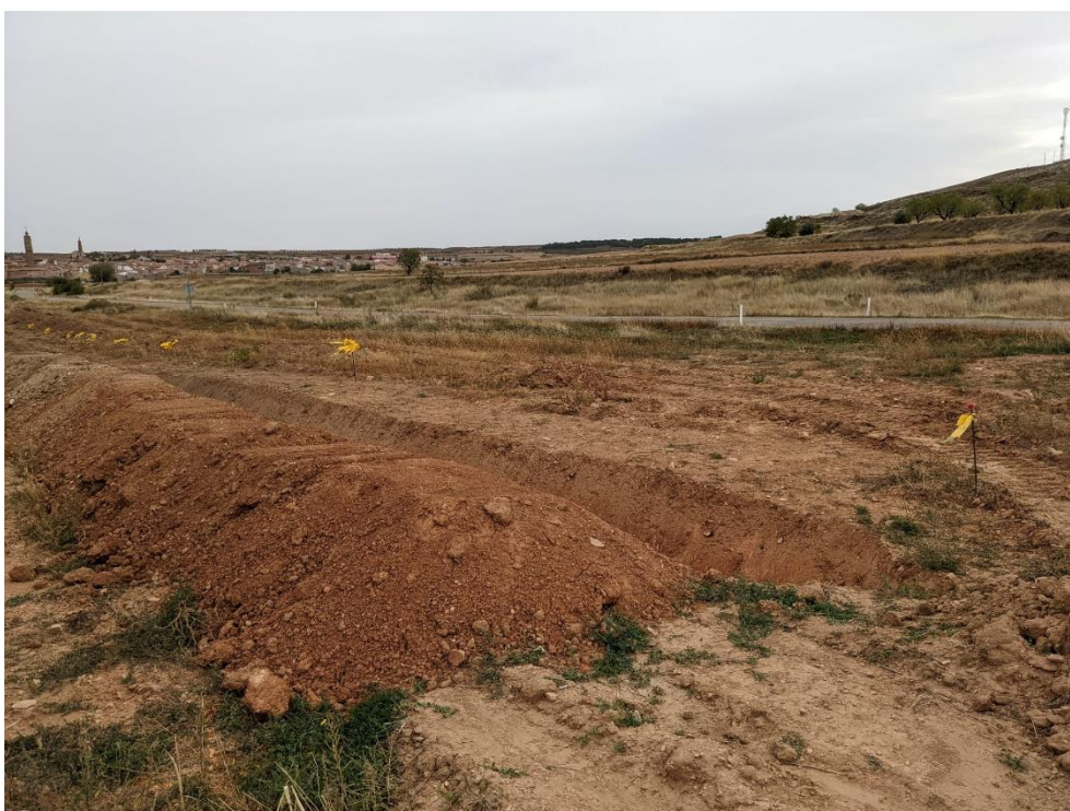
Foto 14. Cuneta y Jarillón para drenaje de protección de la planta.
