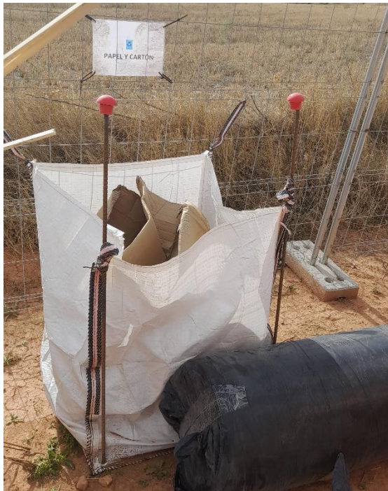
Foto 16. Sacas para recogida de RCD's
