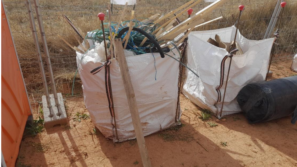
Foto 15. Sacas para recogida de RCD's
