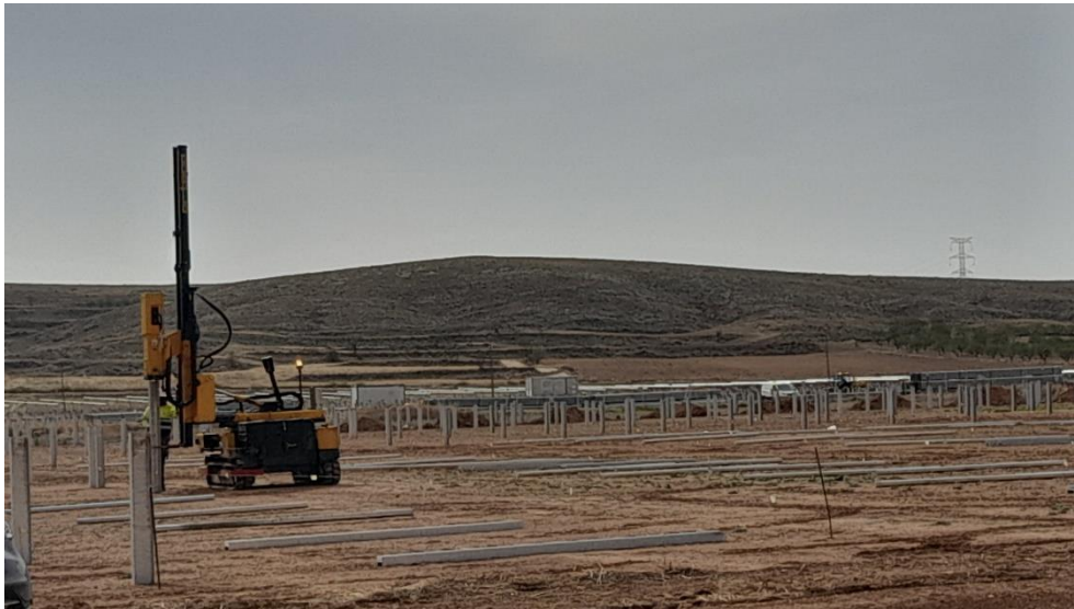
Foto 12. Trabajos de hincado de soportes de seguidores
