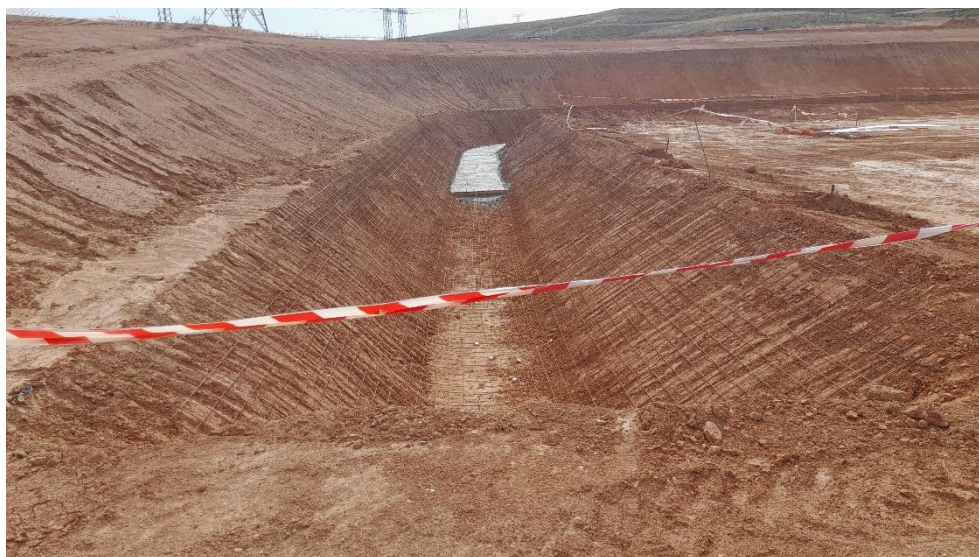
Foto 22. Avance de trabajos de cuneta de drenaje.
