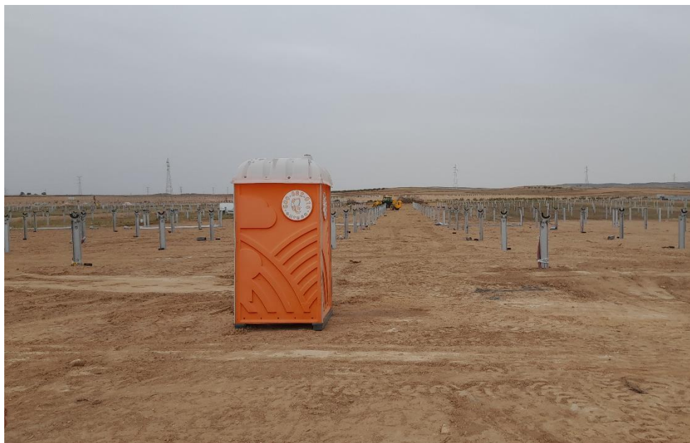
Foto 8. WC químico en zona de obra de montaje de seguidores.
