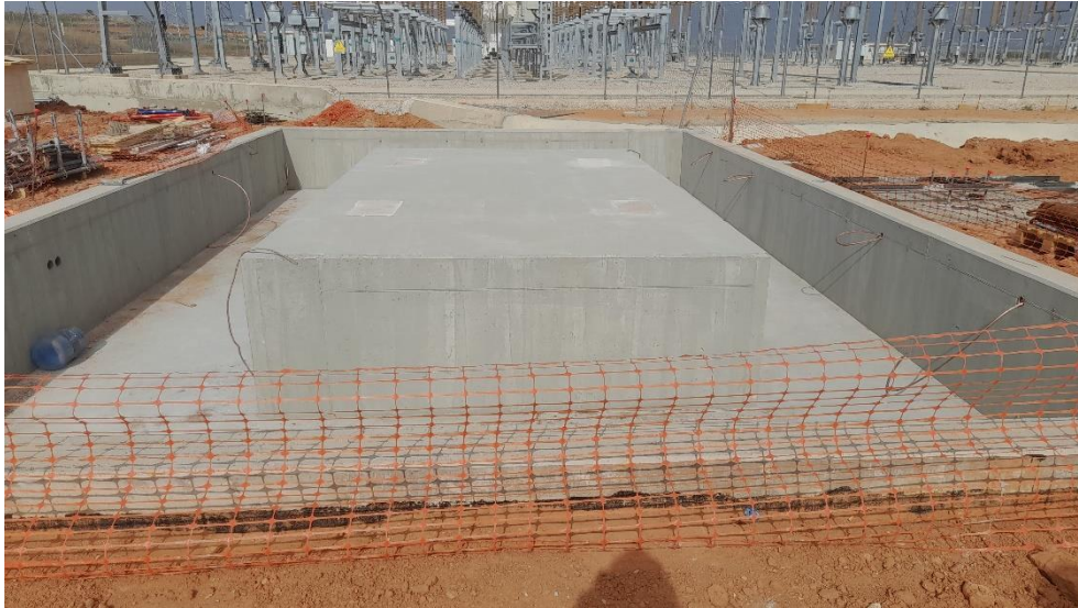
Foto 23. Vista de avance de trabajos de hormigonado
