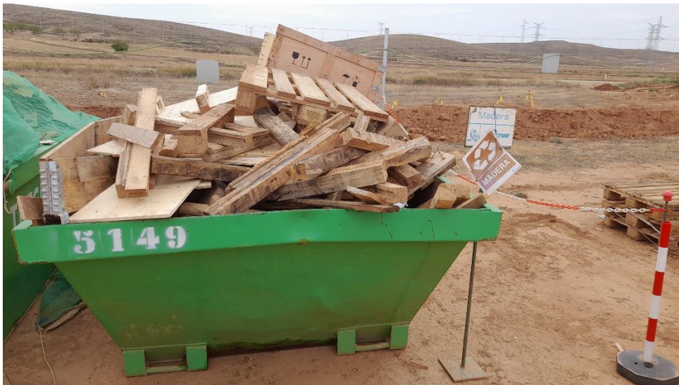
Foto 4. Zona de residuos de construcción y demolición (RCD). Contenedor de madera.
