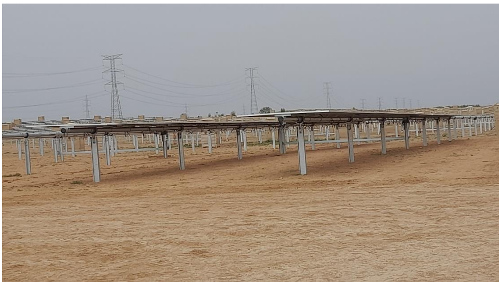
Foto 13. Zanja con cama de arena y tendido de cable.
