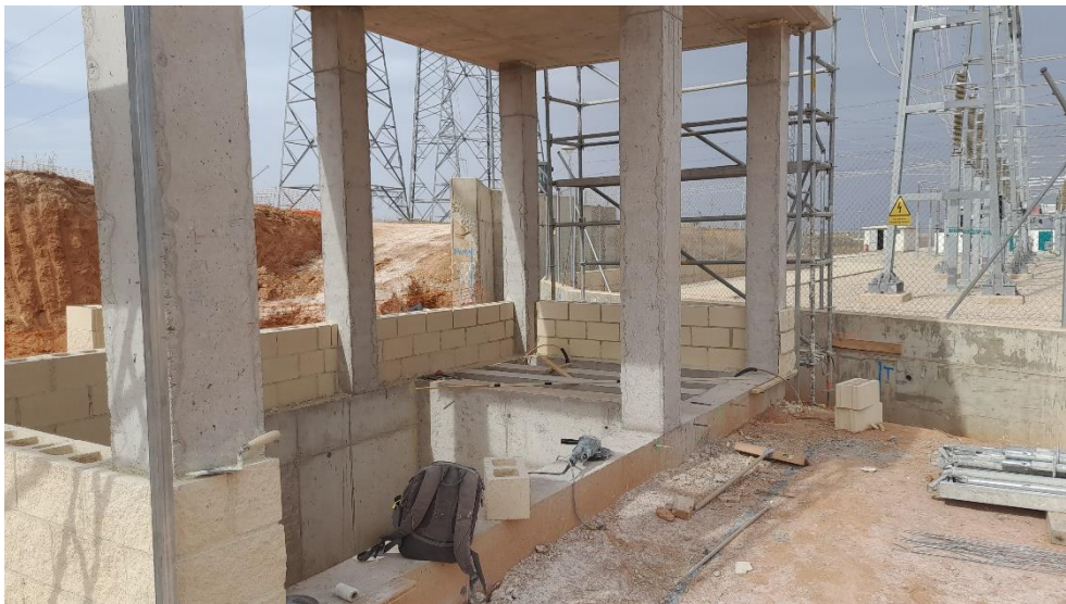
Foto 24. Avance de trabajos en edificio de control de la subestación
