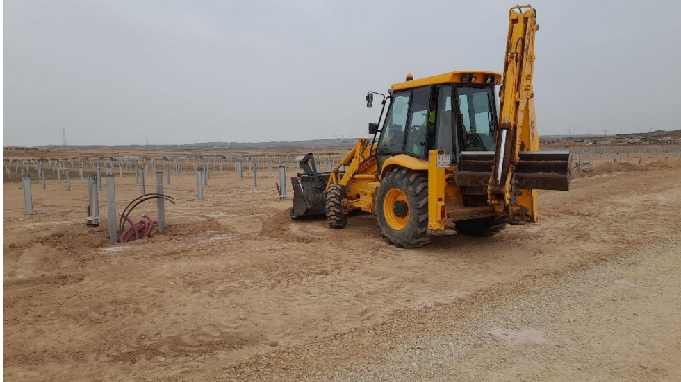
Foto 11. Trabajos de tapado de zanjas
