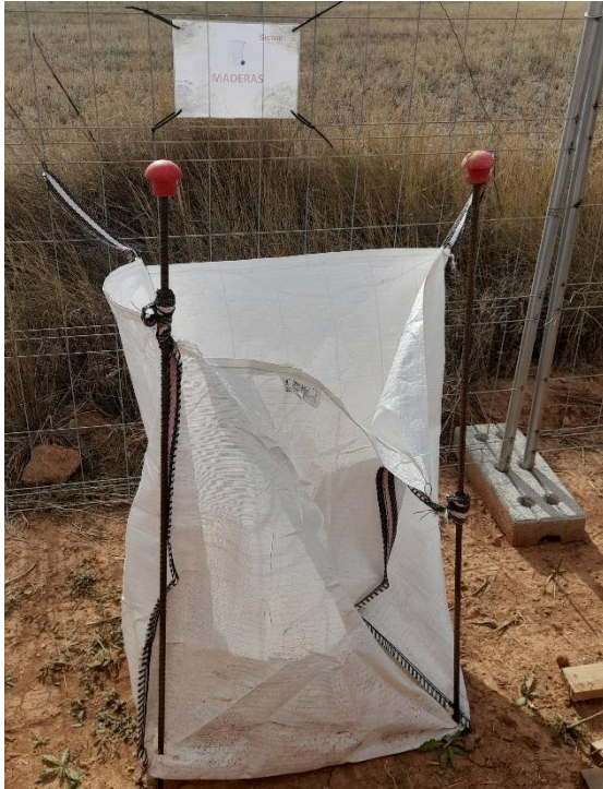
Foto 17. Sacas para recogida de RCD's
