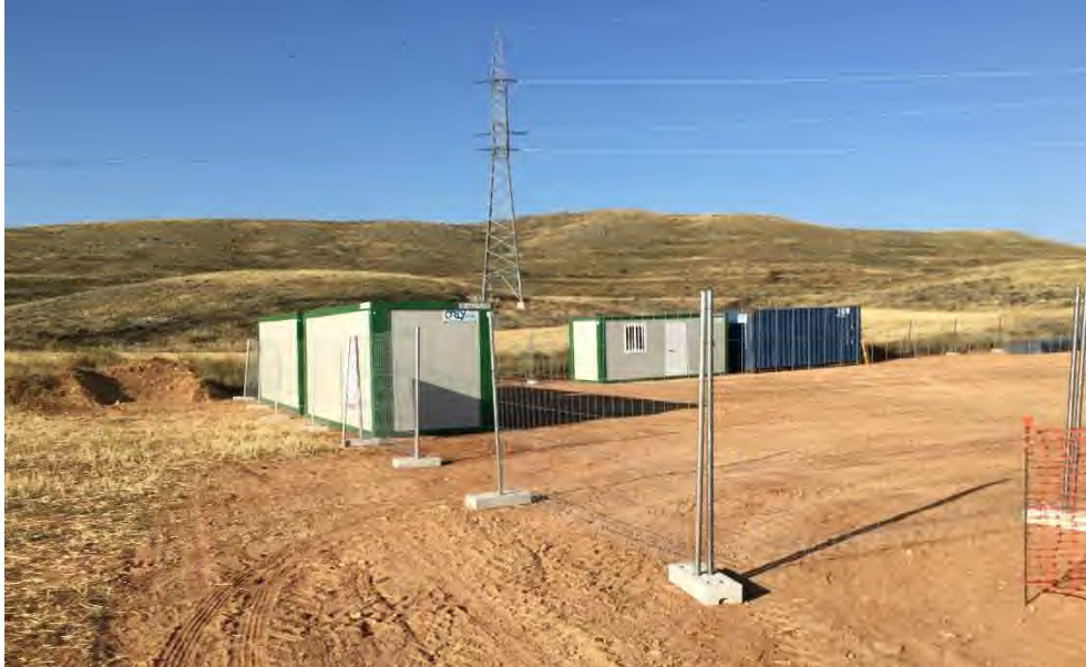
Foto 30. Vallado e instalaciones provisionales de obra en Ampliación SET Muniesa.
