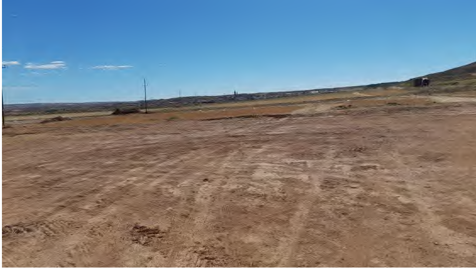
Foto 9. Regularización del terreno entre fincas en zona de seguidores.
