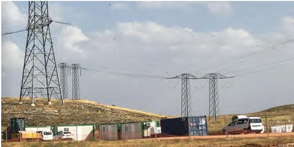
Foto 31. Instalaciones provisionales de obra en Ampliación SET Muniesa.
