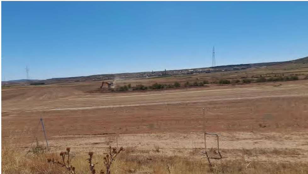
Foto 17. Retroexcavadora retirando almendros. En primer plano, detalle de los postes del vallado.
