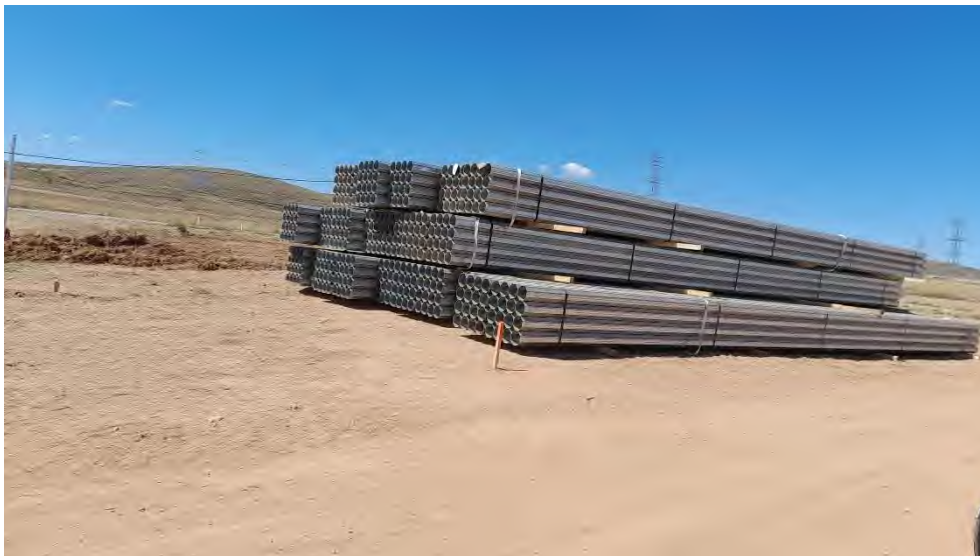
Foto 26. Acopio de tubos de acero galvanizados correspondientes a los ejes de los seguidores.
