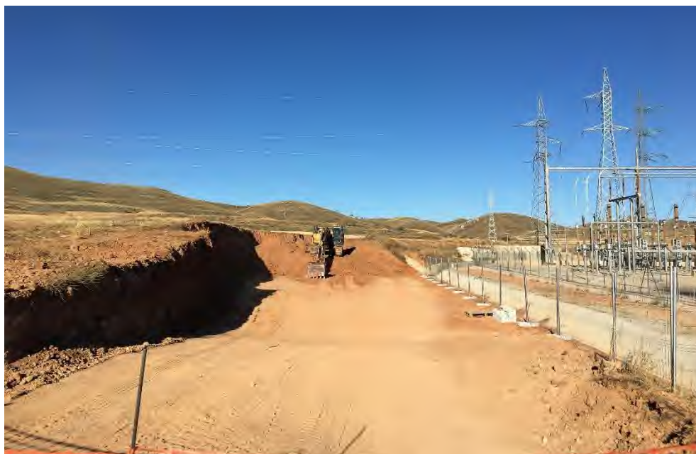
Foto 33. Excavación en Ampliación SET Muniesa.
