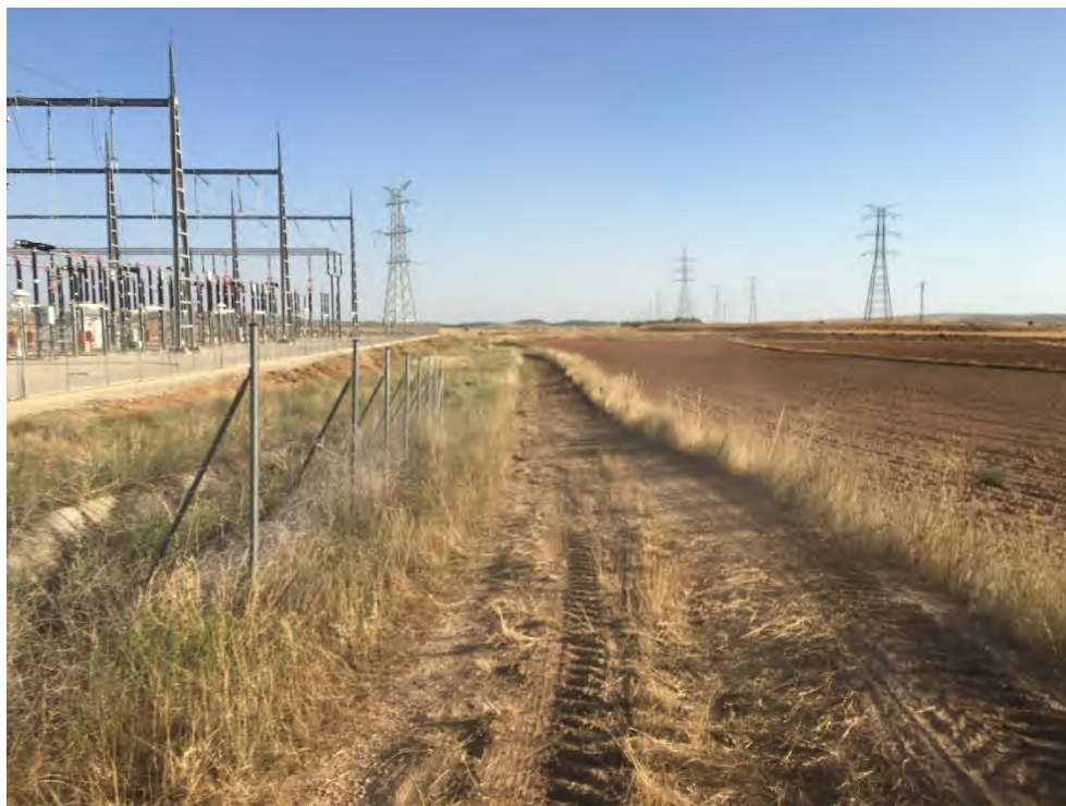
Foto 34. Ejecución de camino provisional de acceso en Ampliación SET Muniesa.
