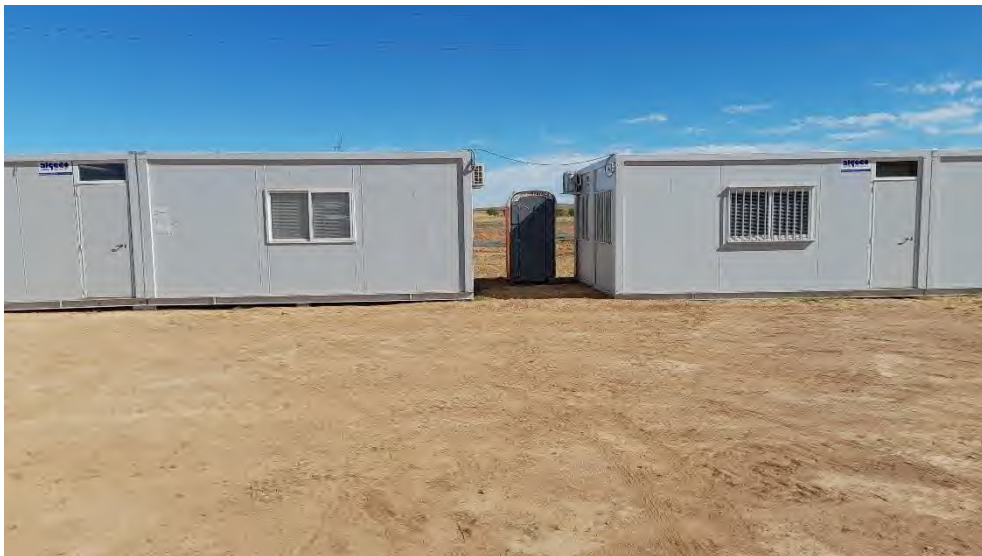
Foto 10. Baños químicos en la zona de oficinas.
