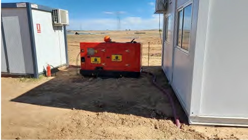
Foto 7. Vista del exterior del campamento de obra.
