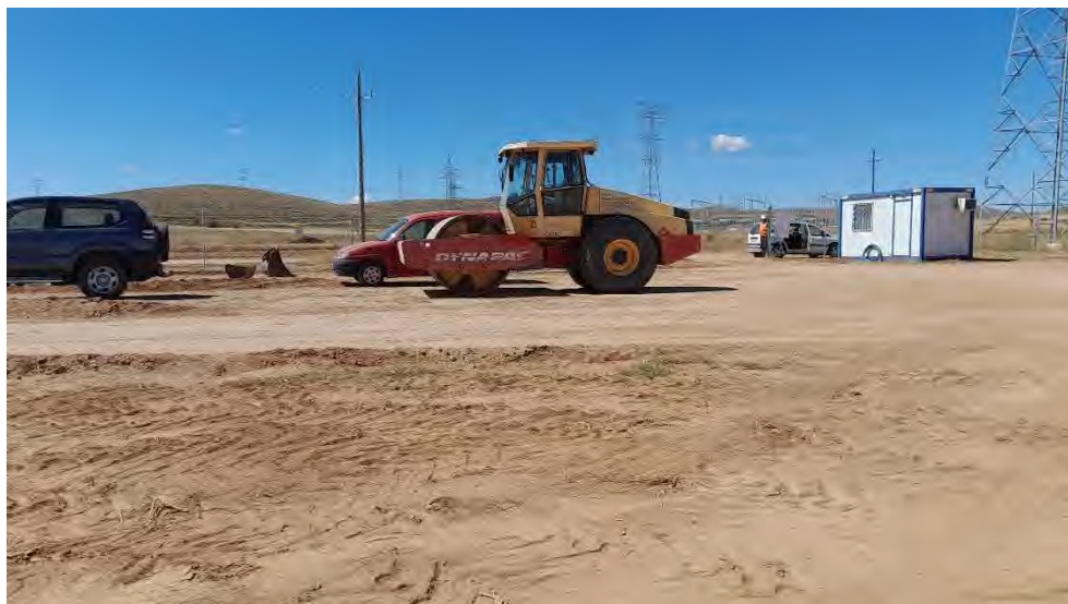
Foto 29. Compactador en zona de obra.
