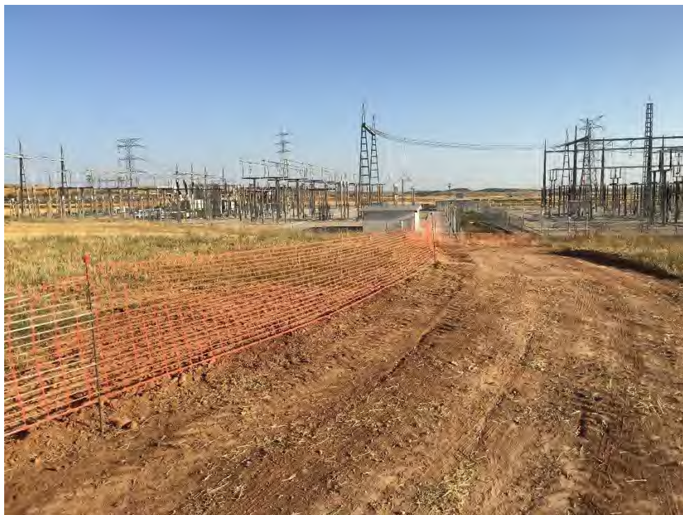
Foto 32. Balizamiento de obra en Ampliación SET Muniesa.
