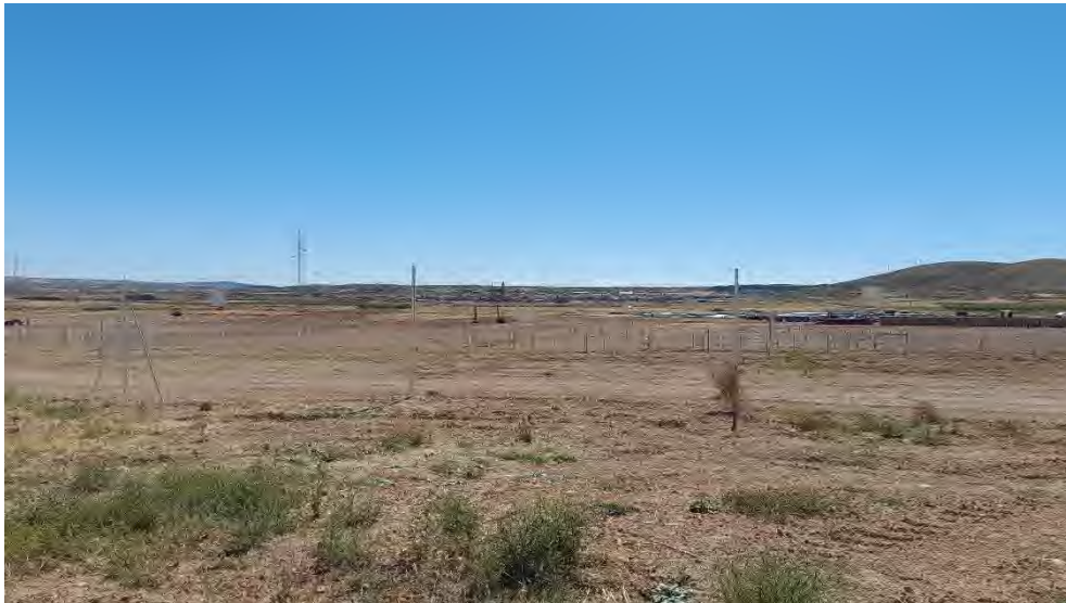
Foto 16. Pequeño tramo del vallado desde el exterior de las instalaciones. Al fondo, hincadoras en funcionamiento
