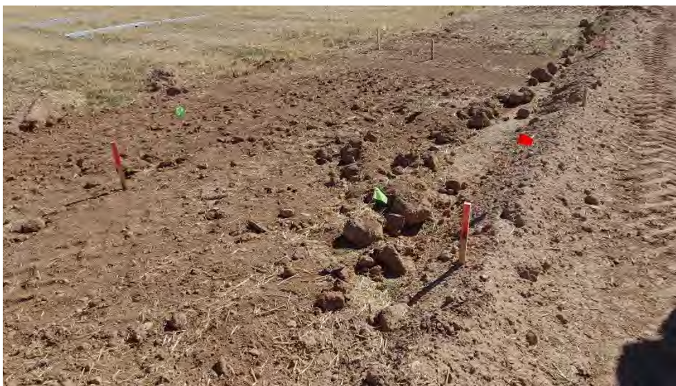
Foto 18. Replanteo de Cetre de Transformación.
