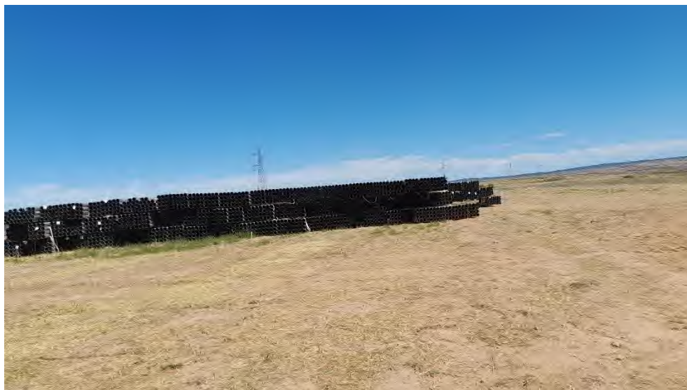
Foto 27. Acopio de tubos de acero galvanizados correspondientes a los ejes de los seguidores.
