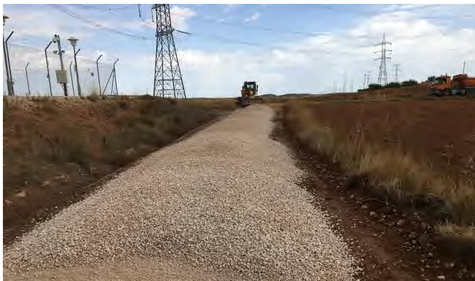
Foto 35. Ejecución de camino provisional de acceso en Ampliación SET Muniesa.
