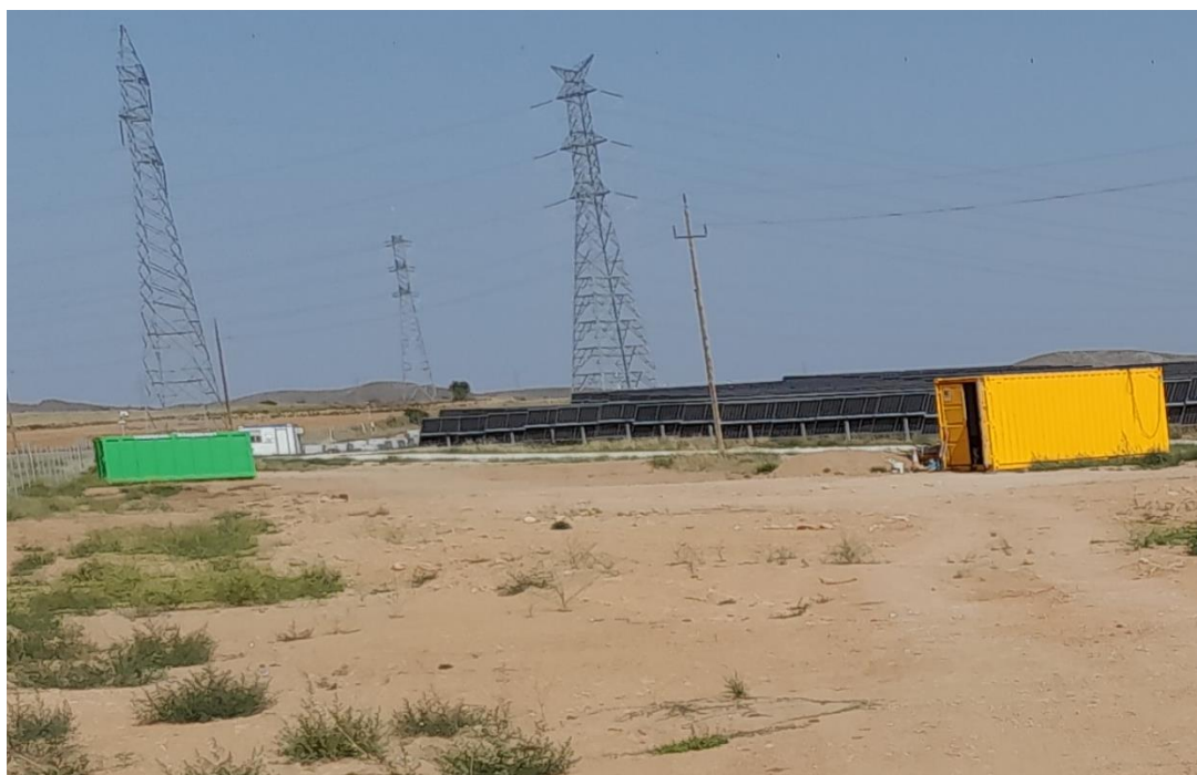
Foto 6. Contenedor de RCDs y almacén en área de instalaciones auxiliares.
