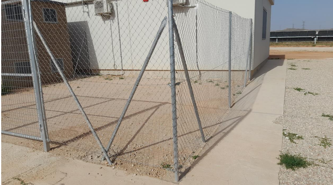
Foto 3. Zona de almacenamiento de materiales para FO en parte trasera de Oficina de O&M.
