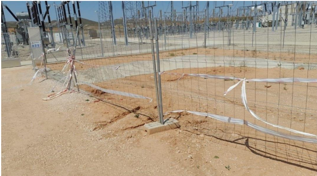
Foto 9. Vista del acceso a subestación: vallado del vial provisional de acceso para protección en obra de drenaje de subestación
