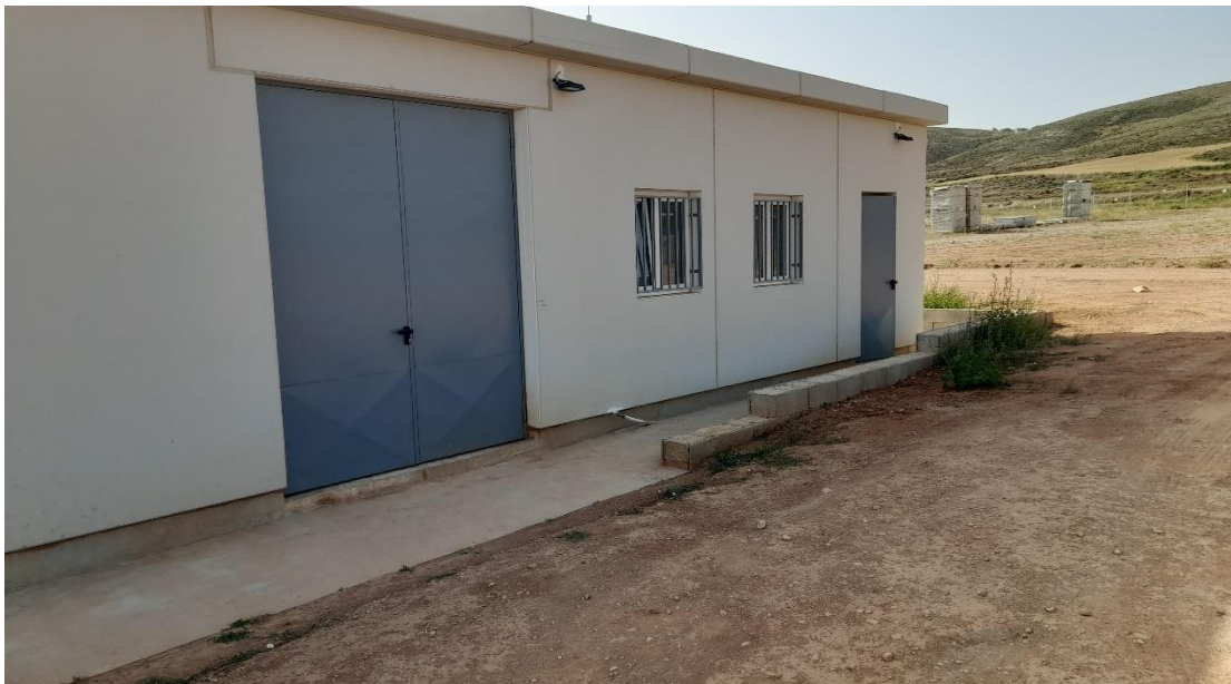
Foto 2. Oficina de O&M finalizada
