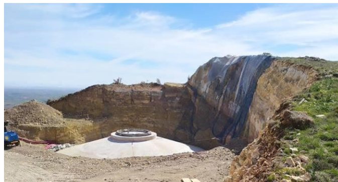
Imagen n.º 1. Vista del talud a estabilizar.
