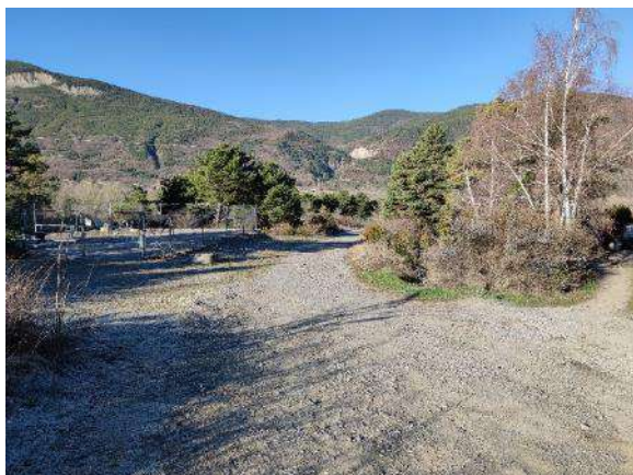
Figura 48: Vista de la parte media del trazado la LAT SET Sierra Plana 1-SET Biescas en las inmediaciones de Orós Bajo.
