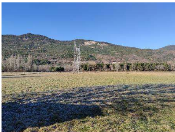
Figura 52: Vista de la parte media del trazado la LAT SET Sierra Plana 1-SET Biescas al este de Argüisal.
